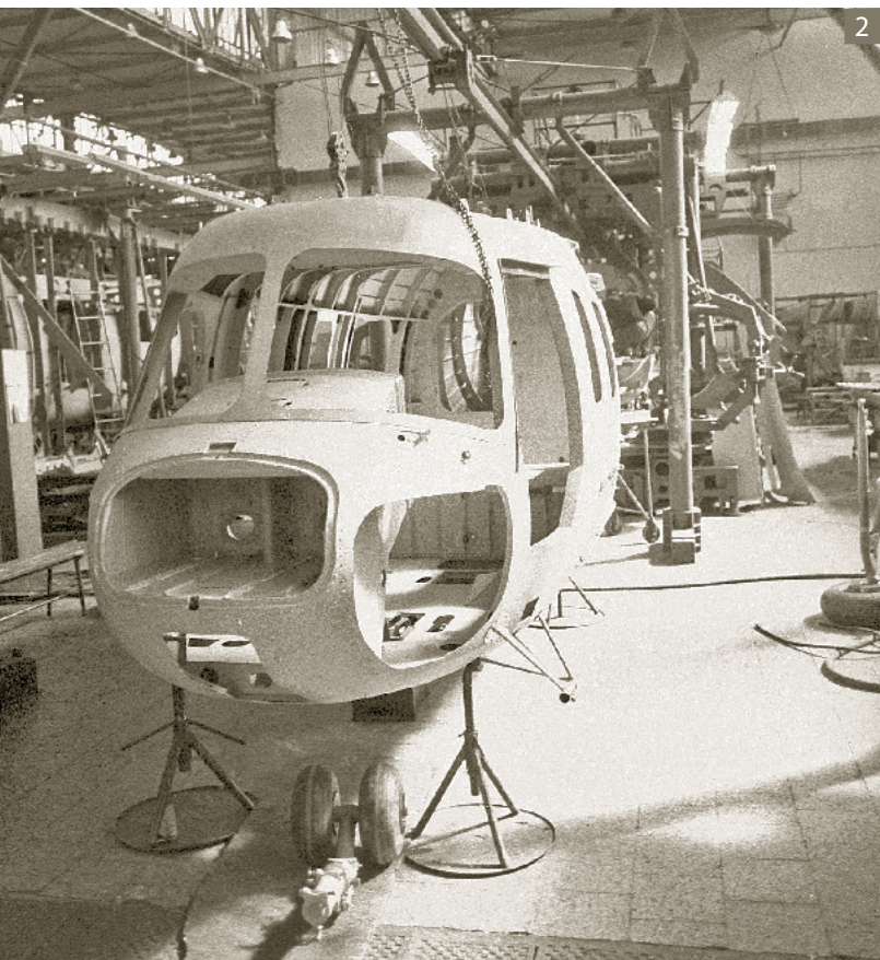
fot. 1-6.: W WSK Świdnik powstało blisko 5500 śmigłowców Mi-2 – wszystkie miały napęd w postaci dwóch turbin GTD-350 oraz przekładni WR-2.
